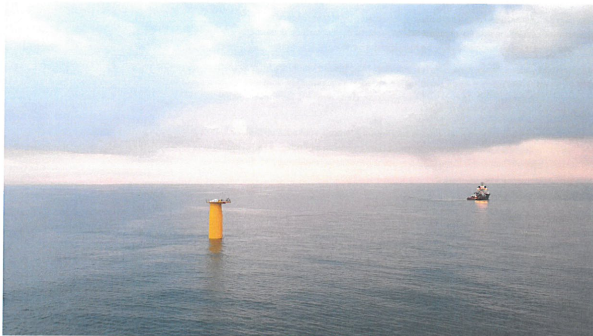
VIND I VEKST: Statoils offshore vindpark Dudgeon i Storbritannia, hvor ett av fundamentene venter på en vindturbin.
